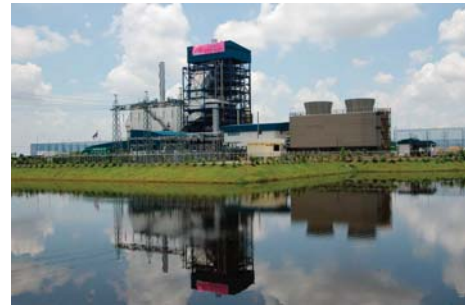
โรงไฟฟ้าชีวมวลเชื้อเพลิงแกลบ ของบริษัท เอ.ที.ไบโอพาวเวอร์ จ.พิจิตร
