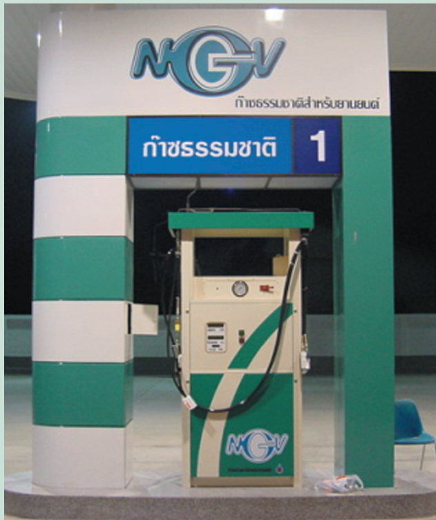
หัวจ่ายก๊าซ CNG ในสถานีบริการ
