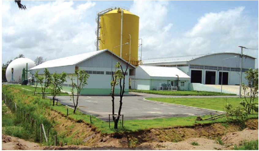
อาคารรับและคัดแยกขยะ
